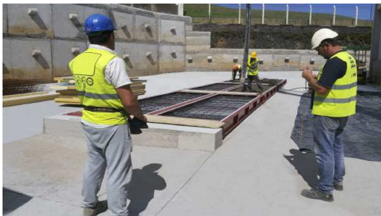
Montage Pont Bascule Métal/Béton - Ponta Delgada - Açores (Portugal)
